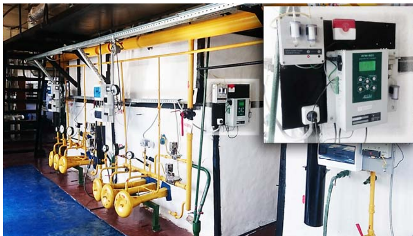
Рис.3. Газоанализатор АГМ-501 на щите управления котла НР-18М-4.
